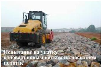
Испытание на укатку одновальцовым катком на насыпном полотне
